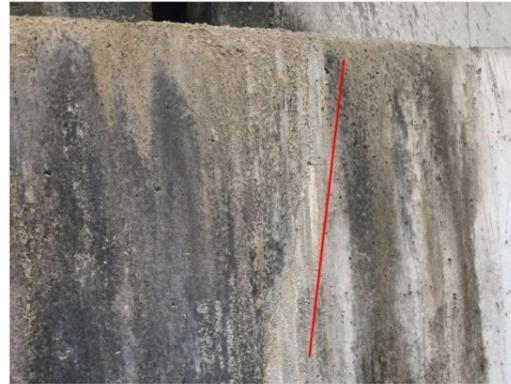
图 3-15: 桥子头大桥（下行）GL-7D 盖梁：左侧竖向裂缝；数量：1 条，长度：0.7m，宽度：0.14mm。
