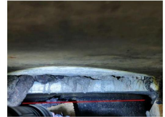
图 3-22: 石坑大桥（下行）ZZ-6-5-5 支座：小桩号面横向开裂；数量：1 条，长度：0.4m，宽度：0.3mm。
