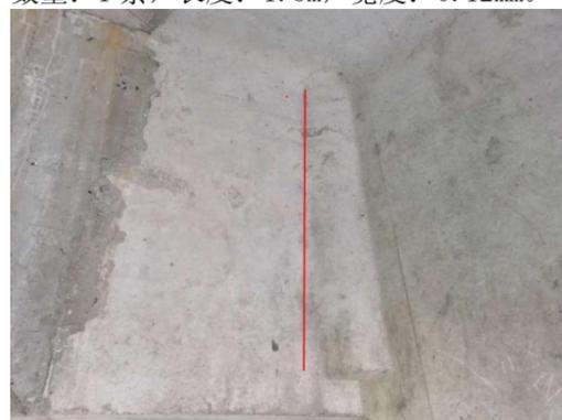
图 3-5: 石坑大桥(上行) 2-1T 梁: 距 2 号墩 0m 处, 左腹板竖向裂缝; 数量: 1 条, 长度: 1m, 宽度: 0.12mm。
