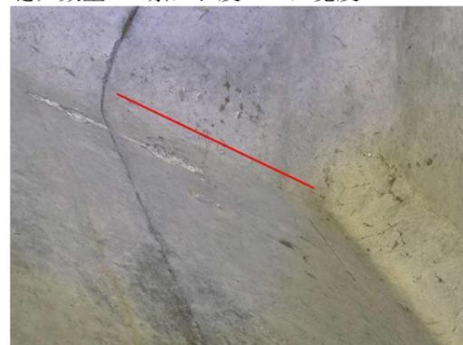
图 3-4: 石坑大桥(下行) 距 0 号台 0m 处, 左侧, 翼板与腹板交接处纵向裂缝; 数量: 1 条, 长度: 0.4m, 宽度: 0.12mm。
