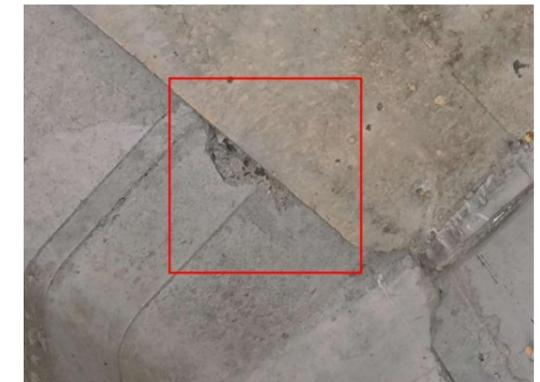
图 3-8: 白莲塘大桥(下行) 1-1T 梁: 距 0 号台 0.1m 处, 左翼缘板破损; 数量: 1 处, 长度: 0.15m, 宽度: 0.05m。
