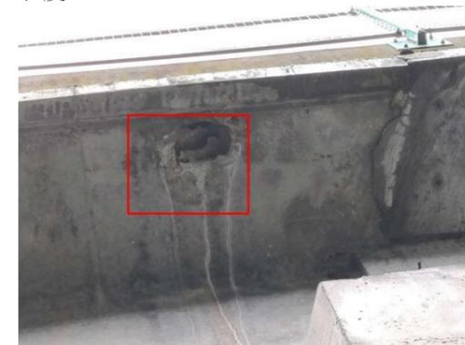
图 3-9: 湖雷互通 B 匝道桥 2-4T 梁: 距 1 号墩 0.5m 处, 左翼缘板破损露筋; 数量: 1 处, 长度: 0.2m, 宽度: 0.1m。
