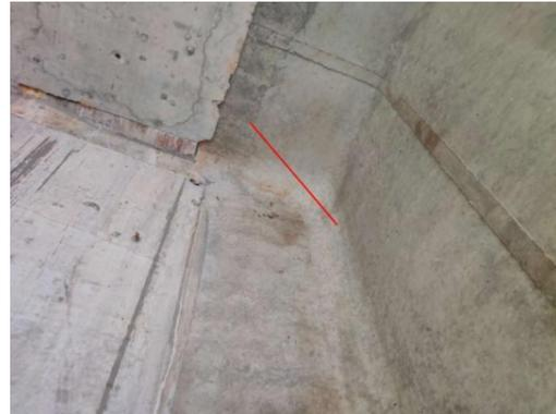
图 3-1: 白莲塘大桥(上行) 2-4T 梁: 距 1 号墩 0m 处, 右翼缘板斜向裂缝; 数量: 1 条, 长度: 0.7m, 宽度: 0.12mm。
