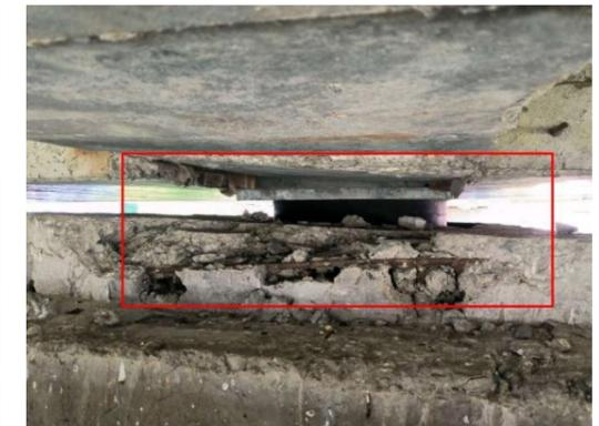
图 3-20: 上湖大桥（下行）ZZ-2-2-2 支座：垫石开裂破损；数量：1 个，长度：0.4m，宽度：20cm。
