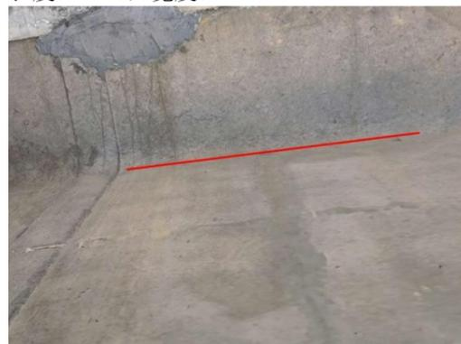
图 3-3: 上湖大桥(下行) 2-1T 梁: 距 2 号墩 0m 处, 左侧, 翼板与腹板交接处纵向裂缝; 数量: 1 条, 长度: 1.5m, 宽度: 0.12mm。
