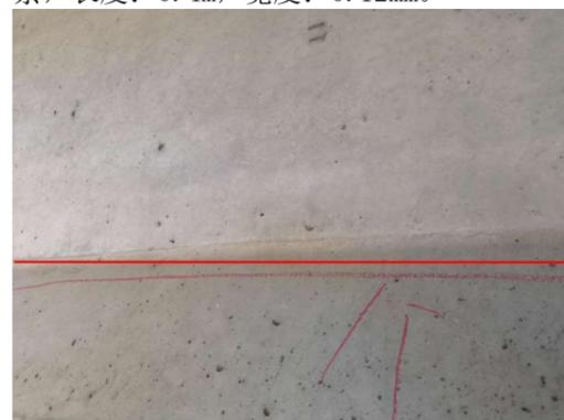
图 3-6: 桐田大桥(下行) 2-2T 梁: 距 1 号墩 5m 处, 右腹板纵向裂缝; 数量: 1 条, 长度: 1m, 宽度: 0.12mm。
