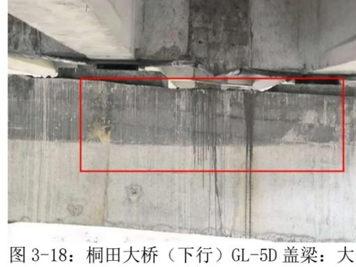
图 3-18: 桐田大桥（下行）GL-5D 盖梁：大桩号面露筋；数量：1 处，长度：0.5m。
