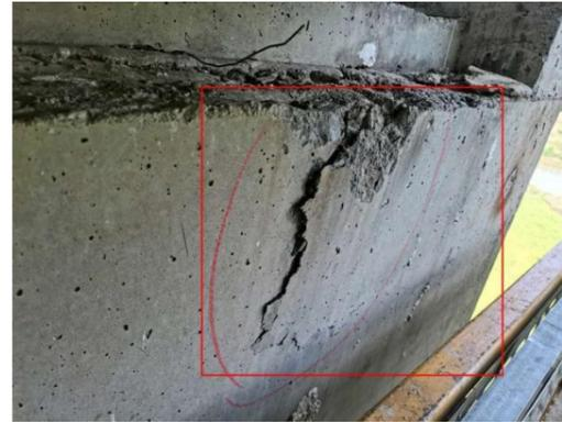
图 3-14: 上湖大桥（下行）GL-7D 盖梁：大桩号面破损；数量：1 处，长度：0.4m，宽度：0.3m。
