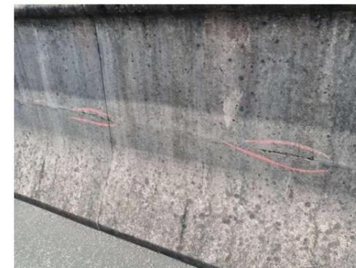
图 3-23: 白莲塘大桥（上行）HL-R-1 右侧护栏：2 号墩顶桥面，右侧露筋；数量：2 处，长度：0.3m。
