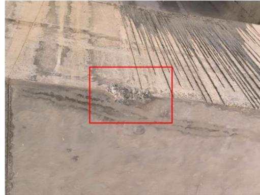
图 3-17: 湖瑶大桥（上行）GL-3D 盖梁：底面破损；数量：1 处，长度：0.15m，宽度：0.1m。
