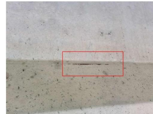
图 3-7: 白莲塘大桥(上行) 2-1T 梁: 距 2 号墩 7m 处, 马蹄左侧面露筋; 数量: 1 处, 长度: 0.3m。
