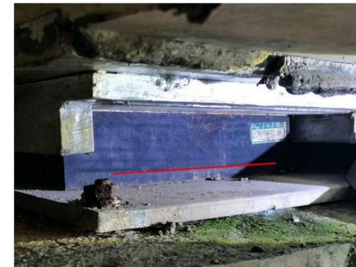
图 3-19: 白莲塘大桥（上行）ZZ-2-2-2 支座：横向开裂；数量：1 条，长度：0.2m，宽度：1mm，备注：小桩侧。
