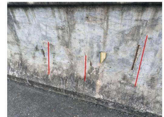
图 3-24: 石坑大桥（上行）HR-R-1 右侧护栏：0 号台顶桥面，右侧露筋；数量：3 处，长度：0.15m。
