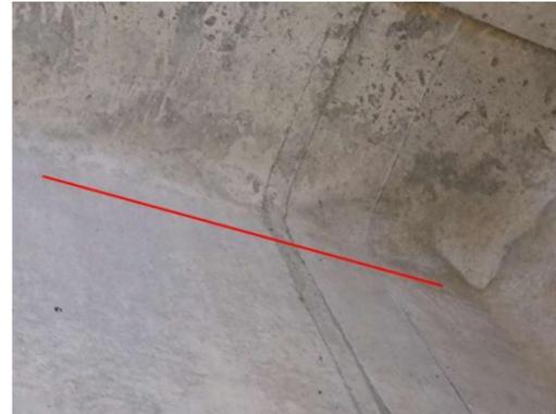
图 3-2: 白莲塘大桥(下行) 1-2T 梁: 距 0 号台 1m 处, 左侧, 翼板与腹板交接处纵向裂缝; 数量: 1 条, 长度: 2m, 宽度: 0.13mm。
