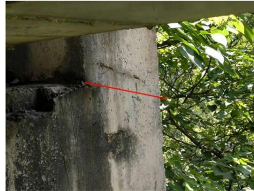
图 3-16: 张屋坝大桥（下行）GL-8D 盖梁：大桩号面露筋；数量：1 处，长度：0.2m。
