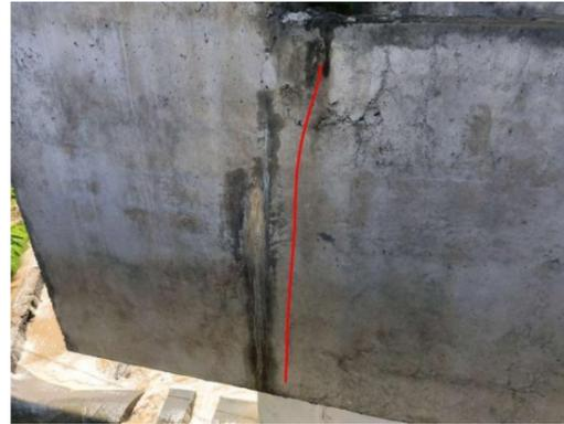
图 3-13: 上湖大桥（下行）GL-3D 盖梁：左侧挡块竖向裂缝；数量：1 条，长度：1m，宽度：0.13mm。
