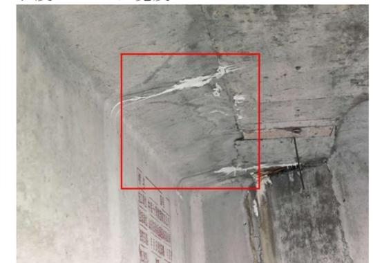
图 3-10: 石坑大桥(下行) 2-1T 梁: 距 1 号墩 1m 处, 左翼缘板渗水泛碱; 数量: 1 处。
