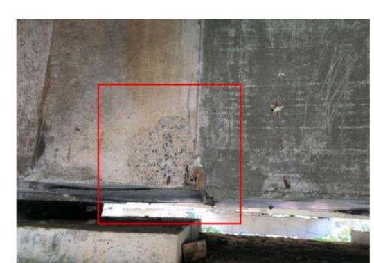
图 3-12: 湖瑶大桥(上行) 1-5-4H 横隔板: 小桩号面破损露筋; 数量: 1 处, 长度: 0.3m, 宽度: 0.2m。
