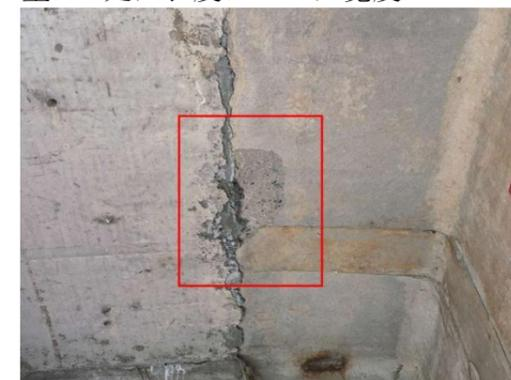
图 3-11: 湖瑶大桥(下行) 5-2T 梁: 距 4 号墩 1m 处, 右翼缘板剥落; 数量: 1 处, 长度: 0.3m, 宽度: 0.1m。
