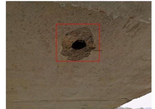
图 3-8: 何家坡 1#大桥(上行) 1DIB 箱梁: 距 1 号墩 10m 起, 距右侧 1m 处, 梁底剥落; 数量: 1 处, 长度: 0.2m, 宽度: 0.2m。
