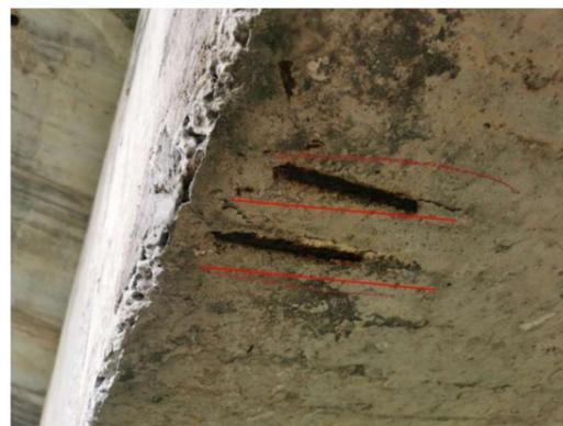
图 3-11: 牛角岗 2#大桥 (上行) 2DIB 箱梁: 距 1 号墩 50m 起, 距右侧 0m 处, 梁底露筋; 数量: 2 处, 长度: 0.3m。
