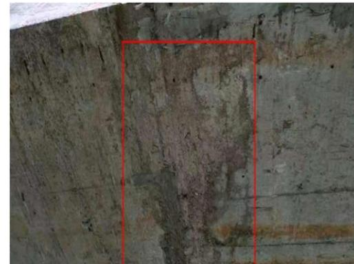
图 3-7: 何家坡 1#大桥(上行) 1DIB 箱梁: 距 0 号台 5m 起, 距右侧 0m 处, 梁底蜂窝、麻面; 数量: 1 处, 长度: 1m, 宽度: 0.8m。
