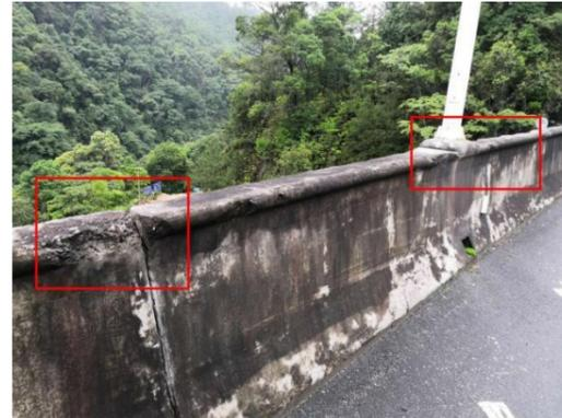
图 3-24：白石岭大桥（下行）HL-N-1 内侧护栏：2 号墩顶桥面破损；数量：3 处，长度：0.25m，宽度：0.1m。
