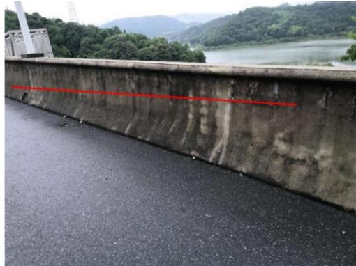
图 3-23：何家坡 1#大桥（上行）HL-R-1 右侧护栏：右侧右侧露筋；数量：36 处，长度：2m。
