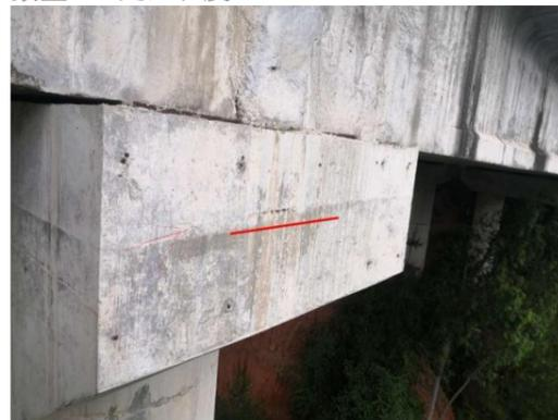
图 3-15: 牛角岗 2#大桥 (上行) GL-6D 盖梁: 距上缘 0.3m 处, 右侧露筋; 数量: 1 处, 长度: 0.2m。
