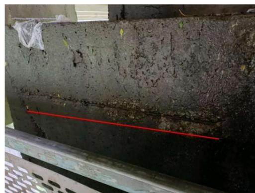
图 3-13: 紫云宫 1 号大桥 (上行) GR-3D 盖梁: 距左侧 0m 处, 距上缘 0.2m 处, 露筋; 数量: 1 处, 长度: 1m。
