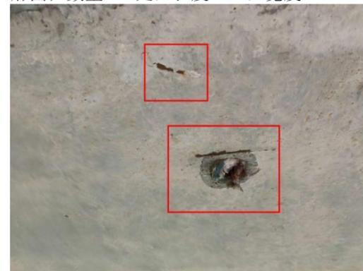
图 3-9: 紫云宫 1 号大桥(上行) 1DIB 箱梁: 距 1 号墩 20m 处, 距右侧 1m 处, 梁底破损露筋; 数量: 2 处, 长度: 0.1m, 宽度: 0.1m。
