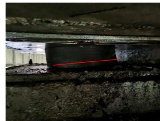
图 3-20: 紫云宫 1 号大桥 (上行) ZZ-4-3-5 支座: 横向剪切; 数量: 1 个, 角度: 10°, 备注: 左侧。
