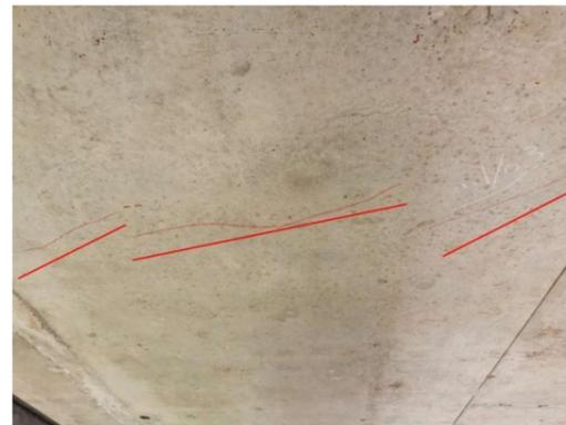
图 3-2: 紫云宫 1 号大桥(上行) 2DIB 箱梁: 距 2 号墩 35m 起, 距左侧 1m 处, 梁底纵向裂缝; 数量: 3 条, 长度: 0.6m, 宽度: 0.13mm。
