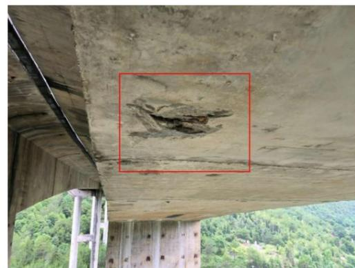
图 3-12: 牛角岗 2#大桥 (上行) 2DIB 箱梁: 距 2 号墩 30m 起, 距左侧 0.1m 处, 梁底破损露筋; 数量: 1 处, 长度: 0.3m, 宽度: 0.25m。
