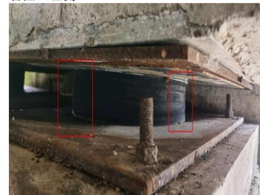
图 3-22: 南塘大桥 (上行) ZZ-21-21-1 支座: 竖向开裂; 数量: 1 条, 长度: 0.05m, 宽度: 0.1mm。
