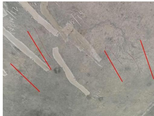
图 3-1: 紫云宫 1 号大桥(上行) 2DIB 箱梁: 距 1 号墩 55m 起, 距右侧 1m 处, 梁底纵向裂缝; 数量: 4 条, 长度: 0.4m, 宽度: 0.12mm。
