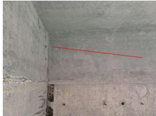
图 3-3: 苦竹山大桥(上行) 3-7T 梁: 距 3 号墩 11m 起, 右翼缘板纵向裂缝; 数量: 1 条, 长度: 0.7m, 宽度: 0.12mm。
