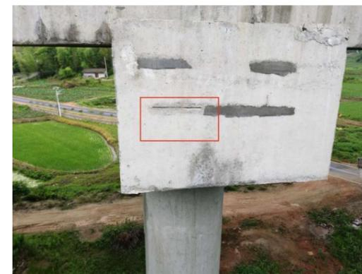
图 3-18: 南塘大桥 (上行) GR-29D 盖梁: 露筋; 数量: 1 处, 长度: 0.3m。
