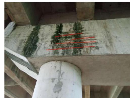
图 3-17: 南塘大桥 (上行) GR-3D 盖梁: 距左侧 1m 处, 小桩号面胀裂剥落; 数量: 4 处, 长度: 2m。
