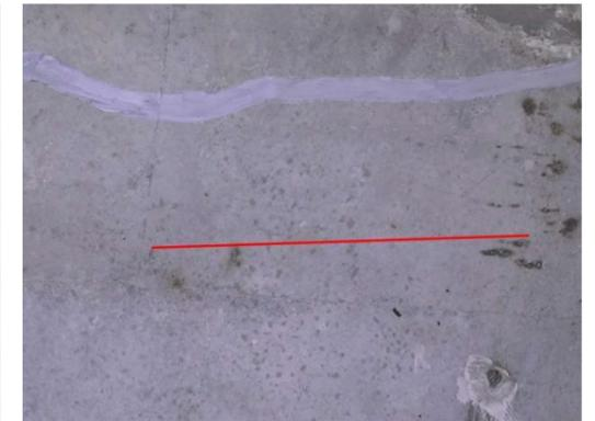
图 3-6: 船岭崇特大桥(上行) 1DINB 箱梁: 距 1 号墩 50m 起, 距右侧 3m 处, 梁顶纵向裂缝; 数量: 1 条, 长度: 2m, 宽度: 0.14mm。
