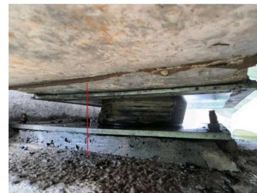
图 3-19: 紫云宫 1 号大桥 (上行) ZZ-4-3-1 支座: 纵向剪切; 数量: 1 个, 角度: 18°, 备注: 大桩侧。
