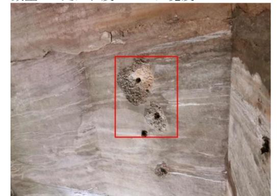
图 3-10: 紫云宫 1 号大桥(上行) 1YYB 箱梁: 距 0 号台 10m 起, 左翼缘板破损; 数量: 2 处, 长度: 0.3m, 宽度: 0.3m。
