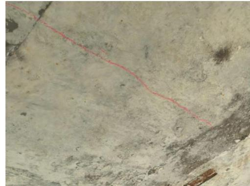
图 3-4: 牛角岗 2#大桥(上行) 2DIB 箱梁: 距 2 号墩 48m 起, 梁底纵向裂缝; 数量: 1 条, 长度: 1m, 宽度: 0.13mm。
