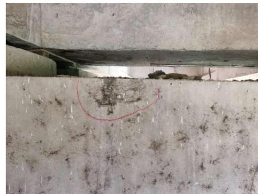
图 3-16: 南塘大桥 (下行) GL-5D 盖梁: 距右侧 6m 起, 距上缘 0m 处, 大桩号面破损; 数量: 1 处, 长度: 0.2m, 宽度: 0.15m。
